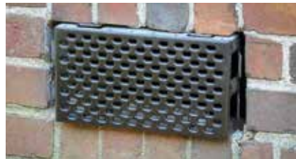
GevelFix-IN met de stelvoetjes uitgebogen
