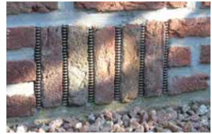
De FlexiGrille 240 is te passen in open stootvoegen tot 24cm hoog.
